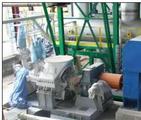
rys.15: Przebieg montażu, z tyłu wymiennik ciepłowniczy
