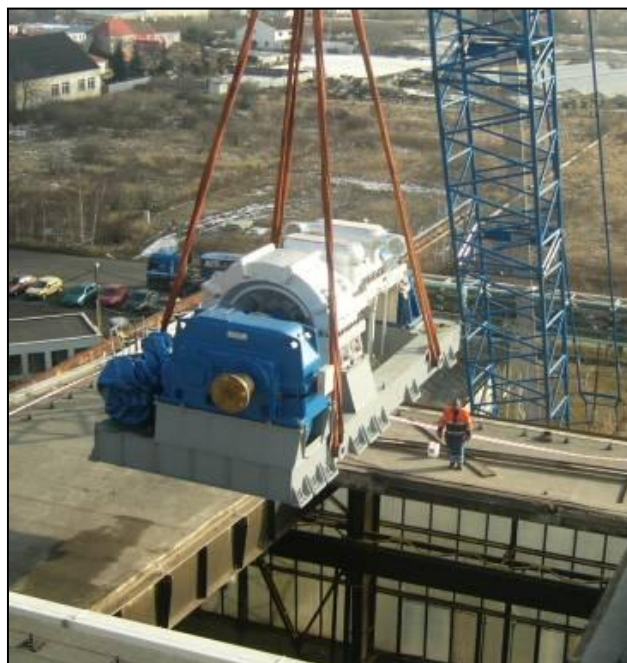
rys.18 : Instalacja turbozespołu na ramie przez dach.
